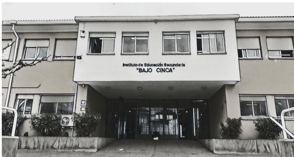
IES BAJO CINCA. FRAGA. Vista principal Edificio A.
